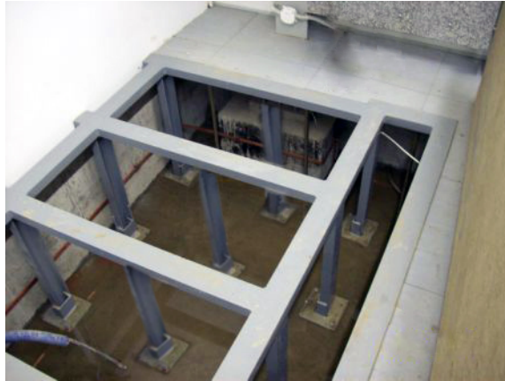
Рисунок 35: Рамная конструкция с продольными лонжеронами
