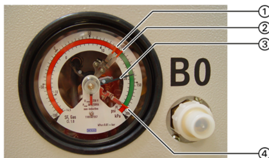
Рисунок 45: Манометр газа на ячейке
