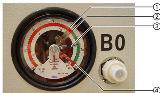
Рисунок 167: Манометр газа на ячейке
