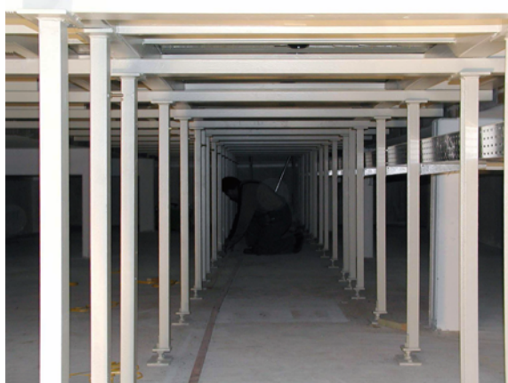
Рисунок 36: Рамная конструкция с продольными лонжеронами (кабельные колодцы)
