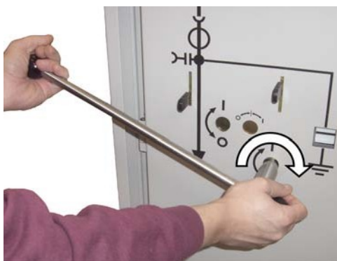
Рис. 83: Рычаг управления на ячейке контактора
