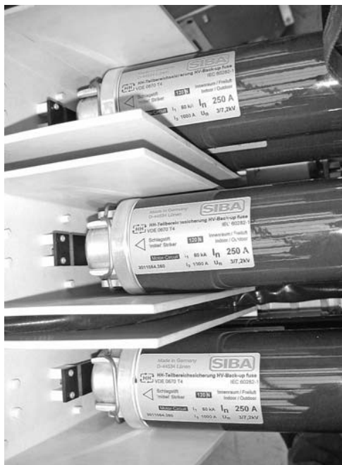
Рис. 162: Вставленные ВВ предохранители
