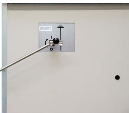
Рис. 114: Рычаг управления в конечном положении, заземляющий нож шины в положении ВЫКЛЮЧЕНО ("OPEN").
