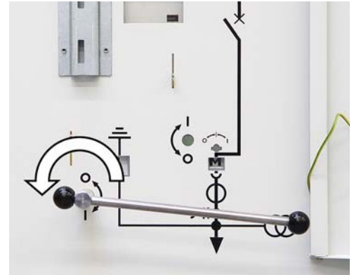
Рис. 91: Рычаг управления ячейки выключателя с моторным приводом
