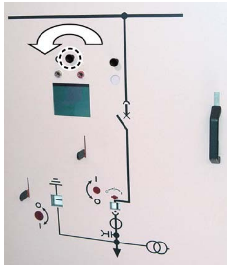
Рис. 66: Поворотная клавиша на ячейке с ручным приводом
