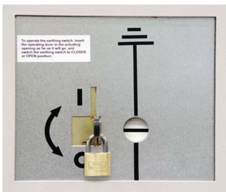
Рис. 118: Заземляющий нож шин находится в положении ВЫКЛЮЧЕНО("OPEN ") версия с моторным приводом, закрыт на навесной замок (для примера)
