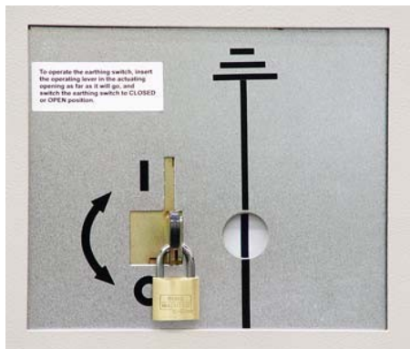
Рис. 105: Заземляющий нож шины находится в положении ВКЛЮЧЕНО ("CLOSED"), для версий с моторным приводом (дано в виде примера)
