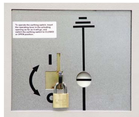
Рис. 95: Заземляющий нож шин находится в положении ВЫКЛЮЧЕНО ("OPEN") и закрыт на навесной замок, версия с моторным приводом
