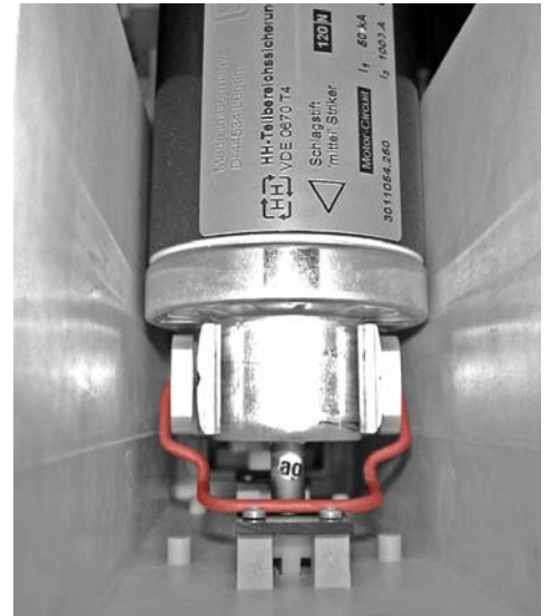
Рис. 159: Предохранительная обойма открыта
