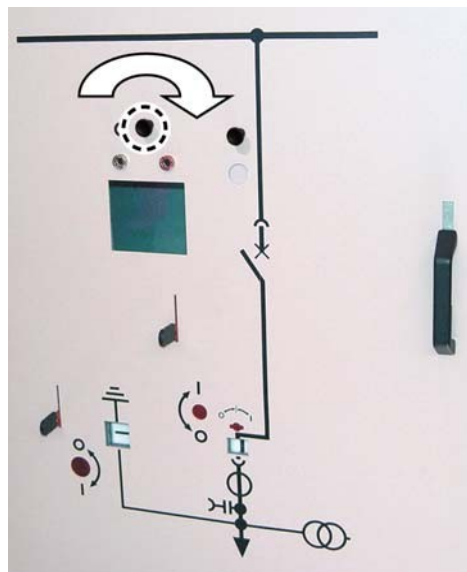
Рис. 59: Поворотная клавиша на ячейке с ручным приводом
