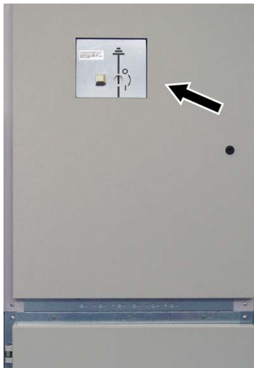
Рис. 106: Органы управления заземляющего ножа системы шин
