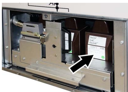
Рис. 164: Место паспортной таблички на трансформаторе напряжения
