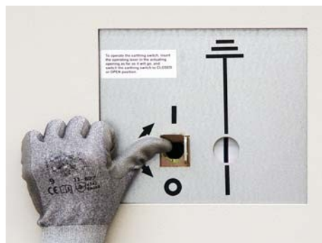
Рис. 109: Управляющая заслонка открыт, версия с ручным управлением
