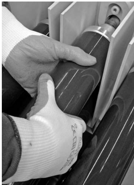
Рис. 160: ВВ предохранитель: Конец без блокировки
