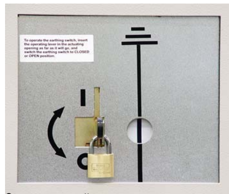
Заземляющий нож шин находится в положении ВКЛЮЧЕНО ("CLOSED") и закрыт на навесной замок, версия с моторным приводом
