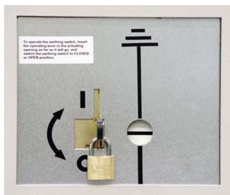
Рис. 103: Заземляющий нож шины находится в положении ВЫКЛЮЧЕНО ("OPEN") для версий с моторным приводом (дано в виде примера).
