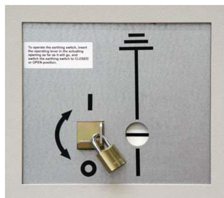
Рис. 94: Заземляющий нож шин находится в положении ВЫКЛЮЧЕНО ("OPEN") и закрыт на навесной замок, версия с ручным управлением
