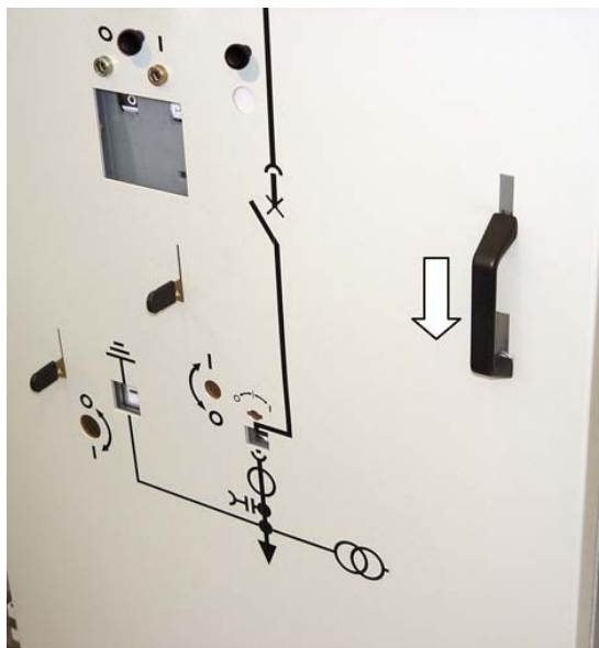
Рис. 46: Закрытие дверцы отсека высокого напряжения ячейки выключателя
