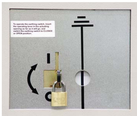
Рис. 116: Заземляющий нож шин находится в положении ВКЛЮЧЕНО ("CLOSED") версия с ручным приводом, закрыт на навесной замок (для примера)
