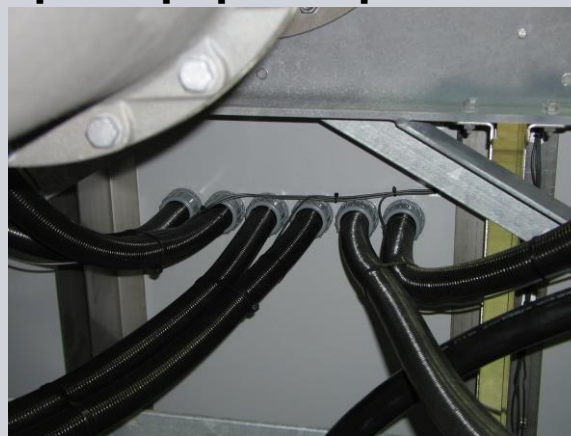
Соединение со шкафом трансформаторов тока
