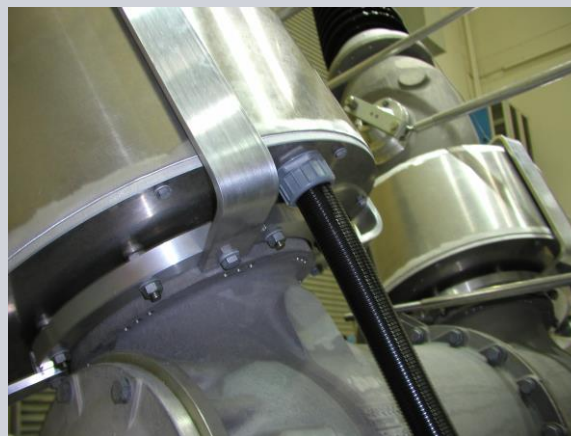
Соединение со шкафом трансформаторов тока
